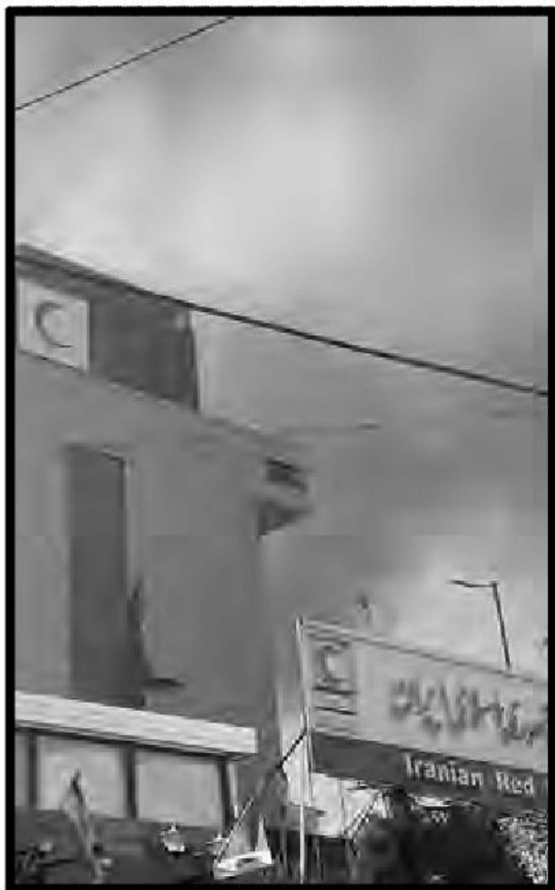
حمله به اطراف ساختمان صلح هلال احمر
